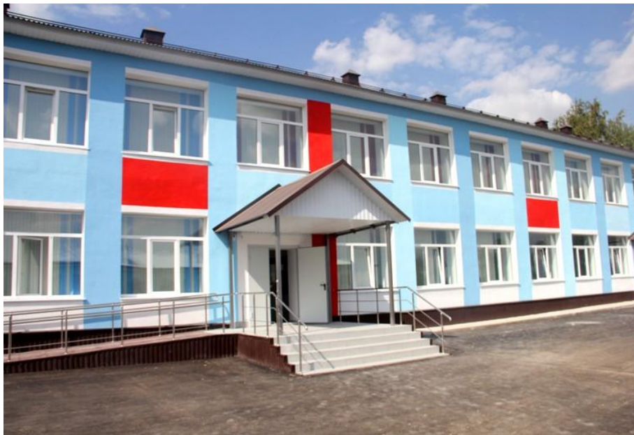
Красносельская школа после капремонта
