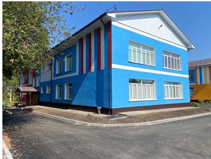
Капитальный ремонт детского сада «Аленушка»
