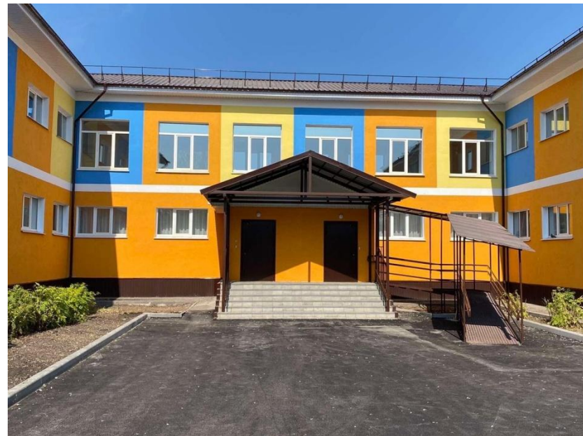
Детский сад «Аленушка» п.Суходол после капремонта
