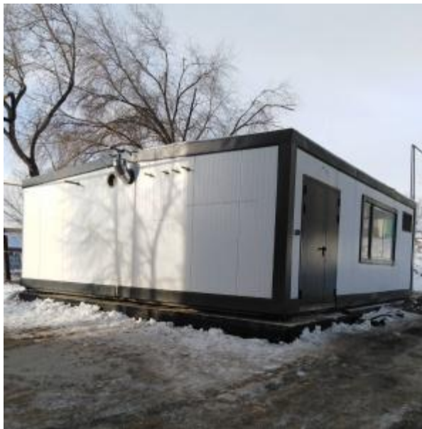
Модульная котельная в п.Серноводск
